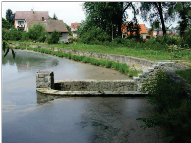
Obrázek 24 Kašnový bezpečnostní přeliv (foto Ezechel)
