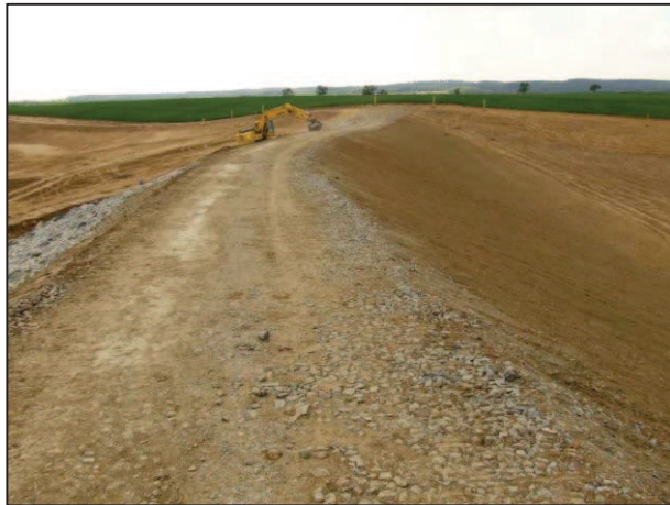
Obrázek 21 Výstavba hráze – vlevo návodní strana, vpravo vzdušná (foto Ezechel)
