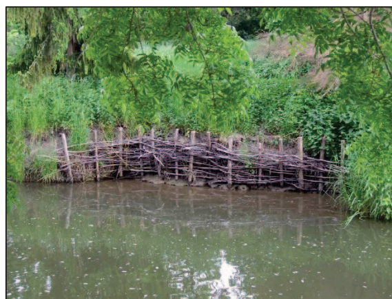
Obrázek 17 Použití zápleťkových plůtek (foto Ezechel)
