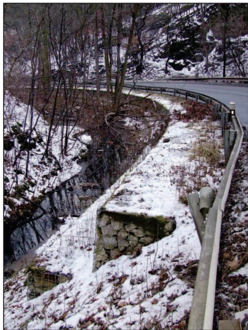
Obrázek 14 Ochrana břehu pomocí gabionů jen u komunikace (foto Ezechel)
