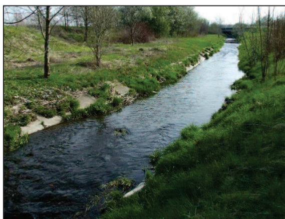
Obrázek 15 Zbytečně použité betonové opevnění (foto Ezechel)
