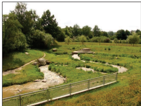
Obrázek 19 Použití obtokového rybochodu v parku (foto Ezechel)
