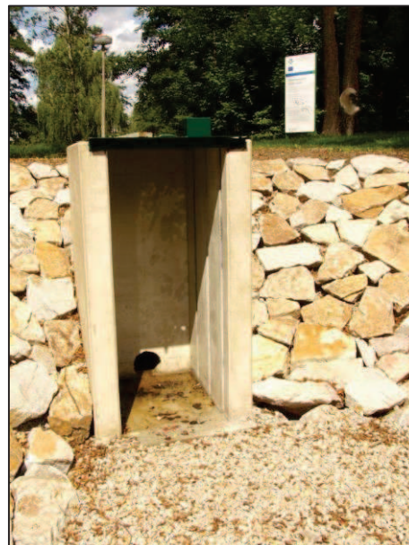
Obrázek 22 Pohled na požerák ze dna rybníka (foto Ezechel)
