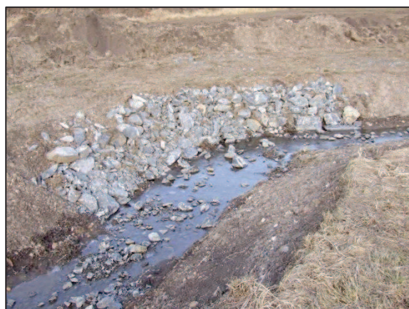
Obrázek 16 Zpevnění břehu jen na více namáhaném vnějším oblouku (foto Ezechel)
