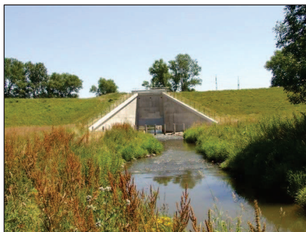
Obrázek 27 Spodní výpust poldru (foto Ezechel)
